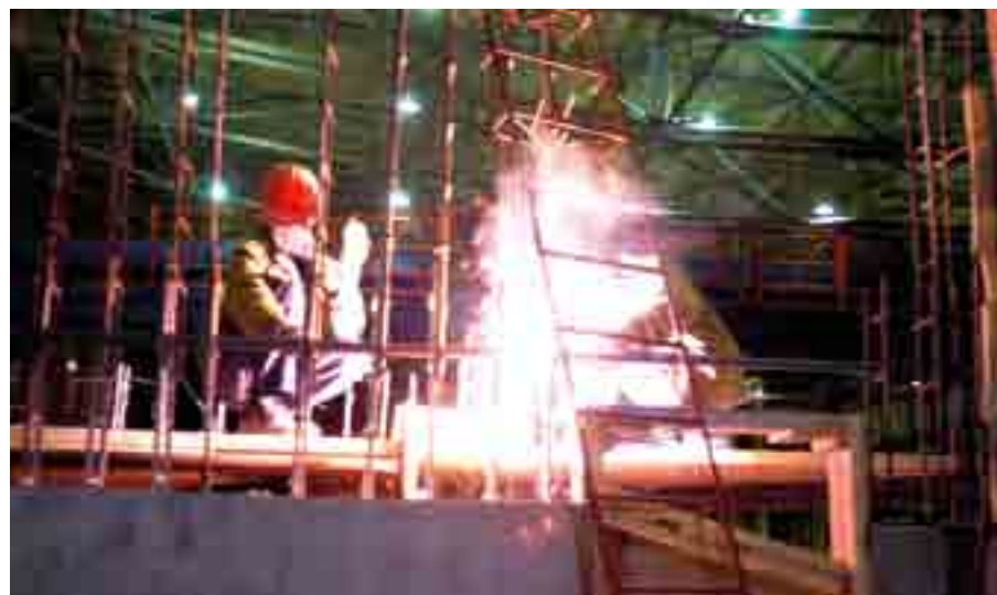
Строительство помещения для проекта «W-ЭХЗ»
