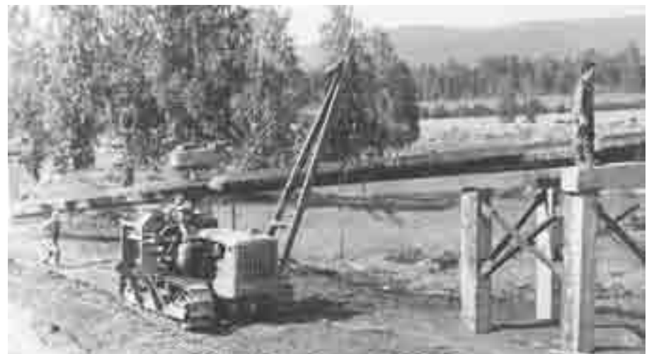
Строительство теплотрассы от ТЭЦ до города, 1961 год
