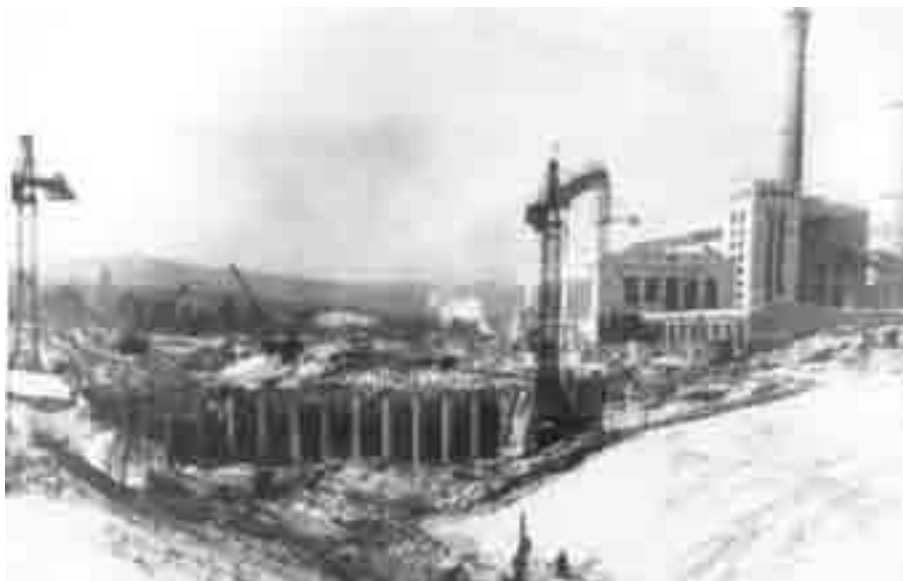
Строительство главного корпуса ТЭЦ
