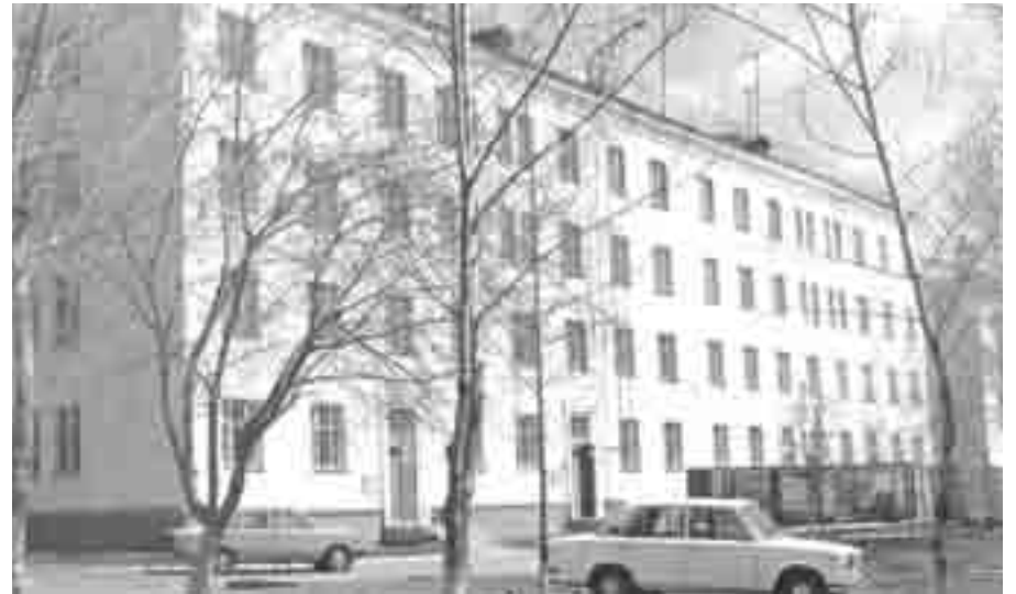
Крупноблочные дома на 32 квартиры в народе прозвали «навлодарскими»
