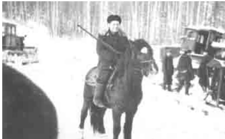
На строительстве ЛЭП, 1959 год
